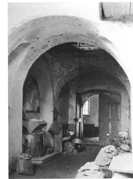
Interiér zámecké kaple s původní výmalbou. NPÚ-ÚOP v Brně, fotoarchív, č. neg. 7400
