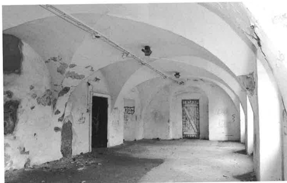
Prostory přízemí klenuté hřebínkovými klenbami. Foto T. Nitra, 2010.
