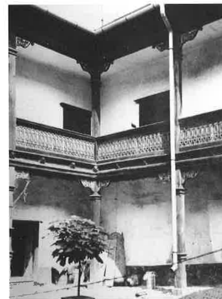
Nádvoří s dřevěnými pavlačemi, 30. léta 20. století, NPÚ-ÚOP v Brně, fotoarchív, č. neg. 7397
