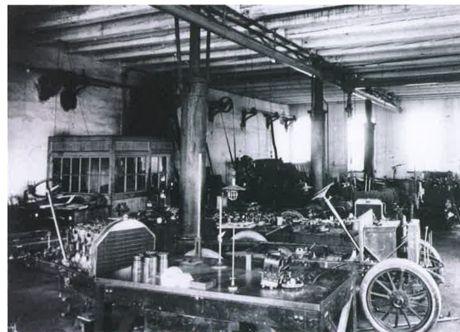
Skromná pracovna H. L. v Kopřivnici - dřevěný přístavek přímo v montážní hale
