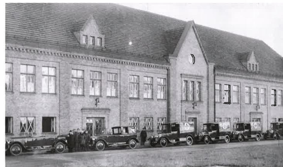
Ředitelská budova kopřivnické vozovky
