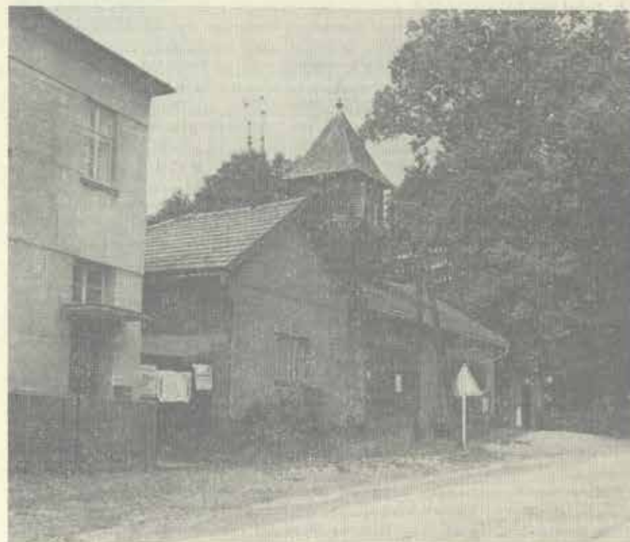
Stará Ves — náves s požární zbrojnicí
