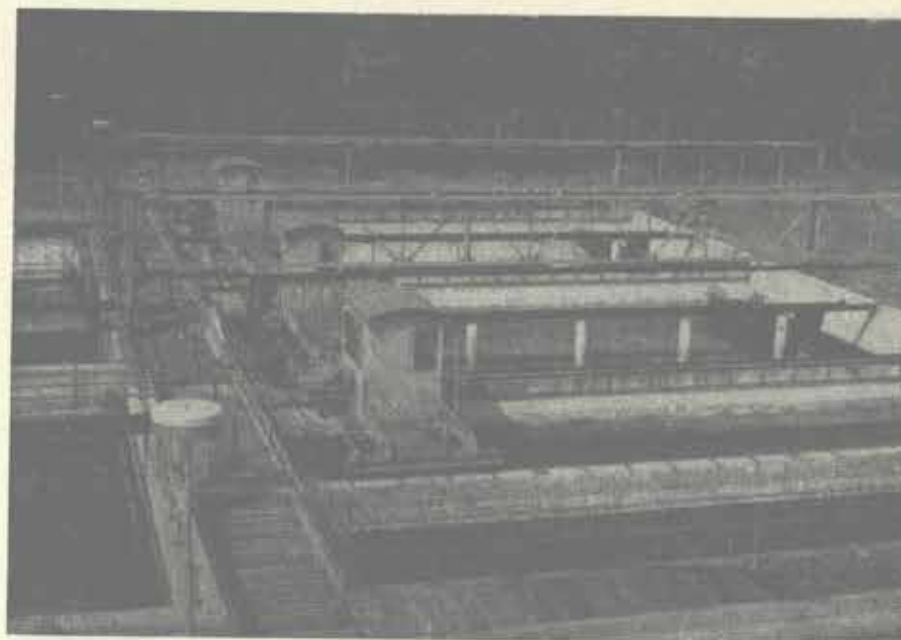
Celkový pohled na městskou čistírnu odpadních vod ve Frenštátě pod Radhoštěm Foto Fr. Kocurek 1979
