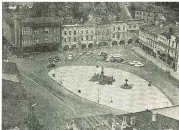
Nově upravené náměstí v Příboře
